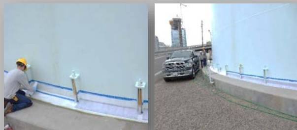
Applying Viscotaq EZ Wrap
